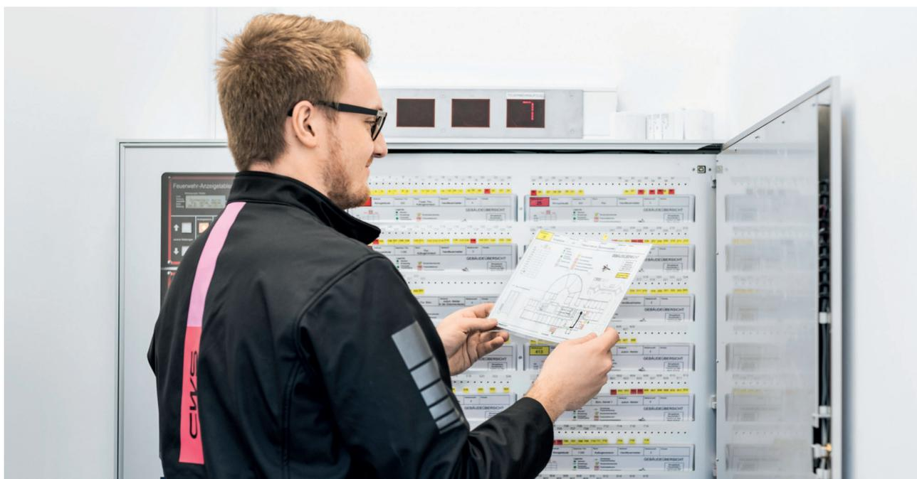
Feuerwehrlaufkarten unterstützen im Brandfall die Feuerwehr bei einer schnellen Lokalisierung des Brandortes, aufgrund der Alarmierung durch die Brandmeldeanlage. Zudem ermöglichen sie eine bessere Orientierung in baulichen Anlagen und geben Aufschluss über: Gebäudegrundrisse, Laufwege zu der ausgelösten Meldegruppe, Feuerwehrschlüsseldepots, Gebäudezugänge und den Standort der Brandmeldezentrale.
