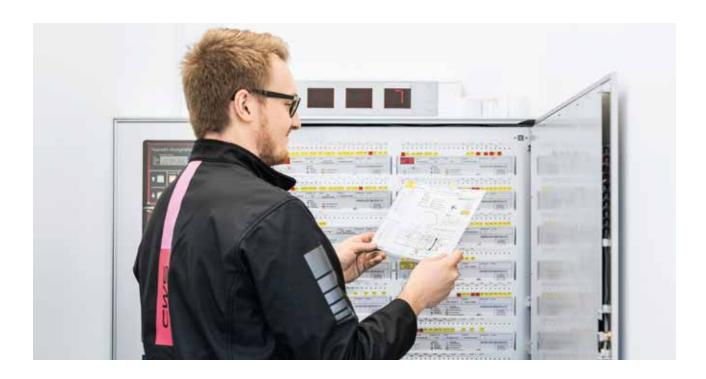
Feuerwehrlaufkarten unterstützen im Brandfall die Feuerwehr bei einer schnellen Lokalisierung des Brandortes, aufgrund der Alarmierung durch die Brandmeldeanlage. Zudem ermöglichen sie eine bessere Orientierung in baulichen Anlagen und geben Aufschluss über: Gebäudegrundrisse, Laufwege zu der ausgelösten Meldegruppe, Feuerwehrschlüsseldepots, Gebäudezugänge und den Standort der Brandmeldezentrale.
